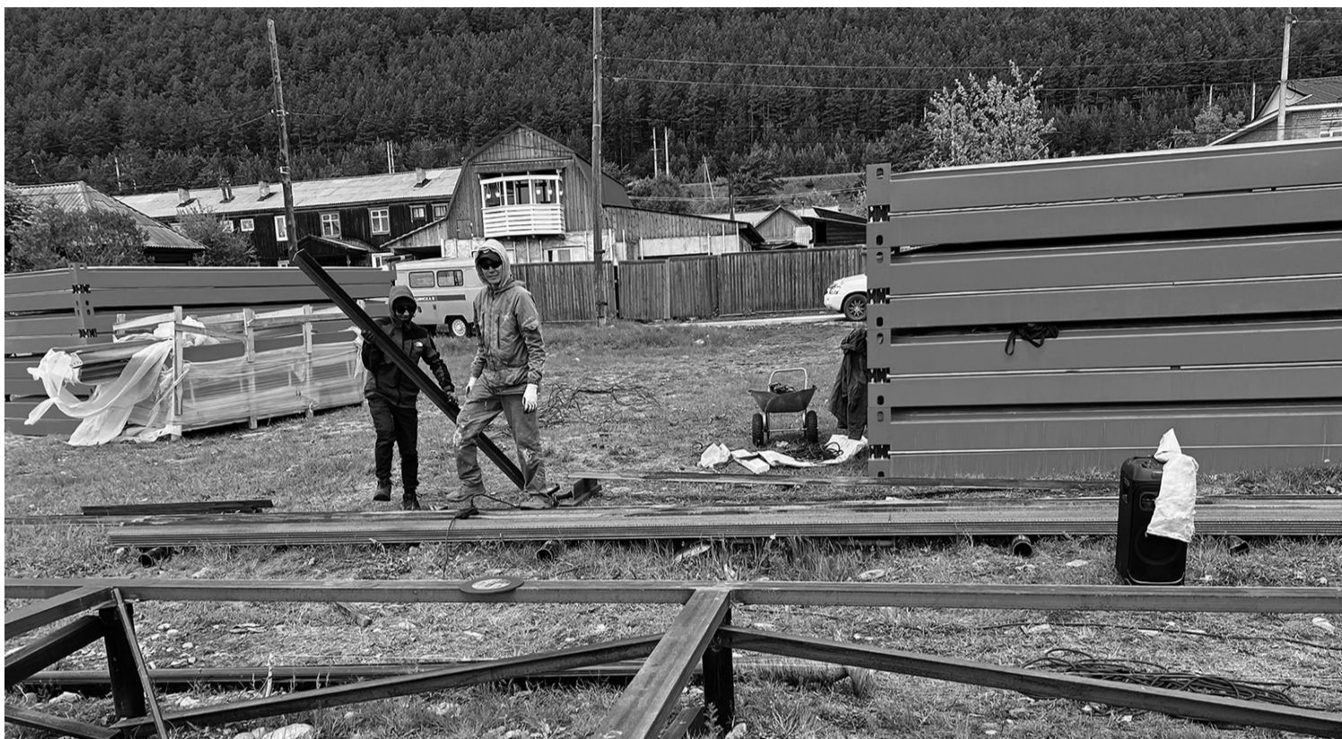
Строительство быстровозводимой модульной поликлиники Нижнеангарской ЦРБ
